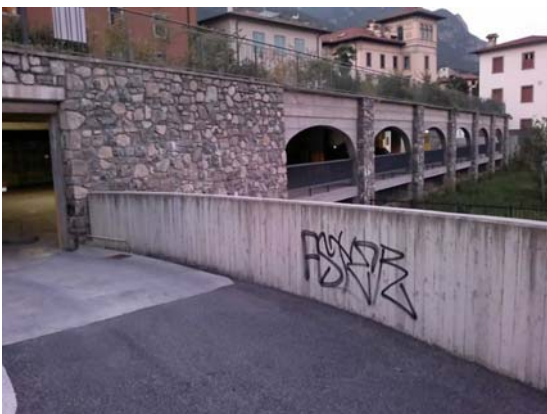
8 AUTORIMESSA TADINI microaeroabrasione su 4 punti
