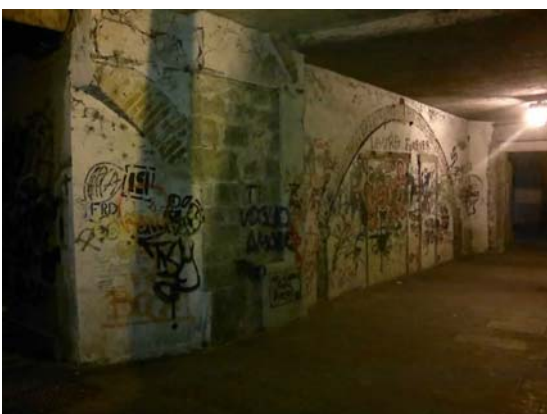
2 PORTICETTO PORTO 1 - Sabbiatura a bassa pressione di laterizi presenti, fondo inibente intonachino e antiscrittura
