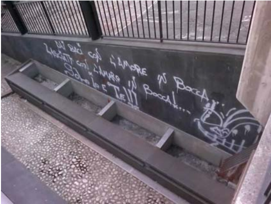
24 LAVATOIO VIC. SAN GIOVANNI AL RIO - microaeroabrasione a bassa pressione più anticrittina
